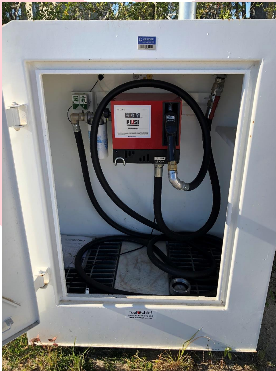
Fuelchief BASIC Package de pompage dans un Fuelchief DC25 double enveloppe
